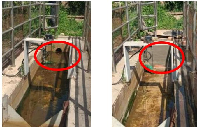
图 2 污水排口封闭前后
