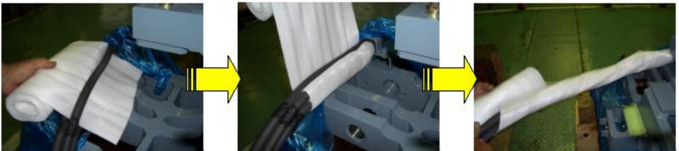
(4) 卷包终端、覆盖连接器的接触片侧用粘着胶布卷包，如下示意图。
