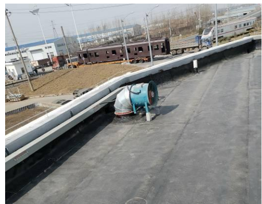
曝光室室顶排风口
